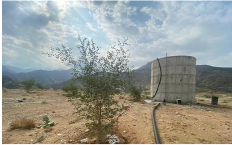
منشآت تخزين المياه
